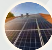
Ausbau Photovoltaik Gesamtleistung rd. 860.000 kWh/a
